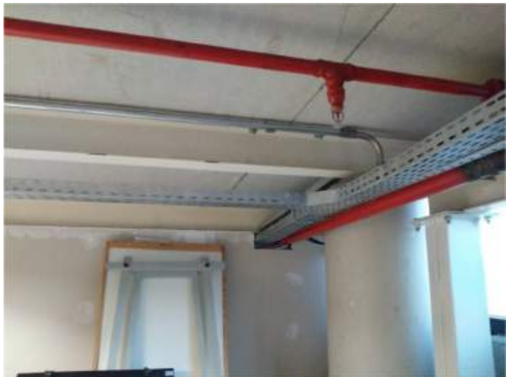
Estrutura de eletrocalhas para passagem dos cabearmentos de rede e ótico.
