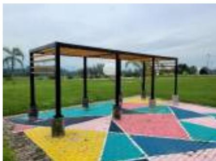
Projeto pertencente ao Nexus Living, que está em processo de finalização. Pergolado em estrutura metálica, com pérgolas em madeira e pilares em concreto.
