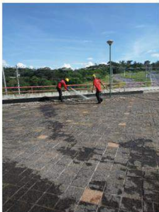
Limpeza e desentupimento de grelhas e tubulação de águas pluviais na Laje (acima da Aeroconcept e Visiona).
