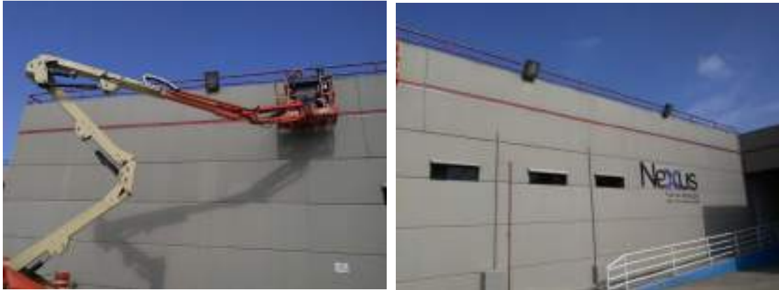
Pintura da parede externa próxima ao Nexus.
