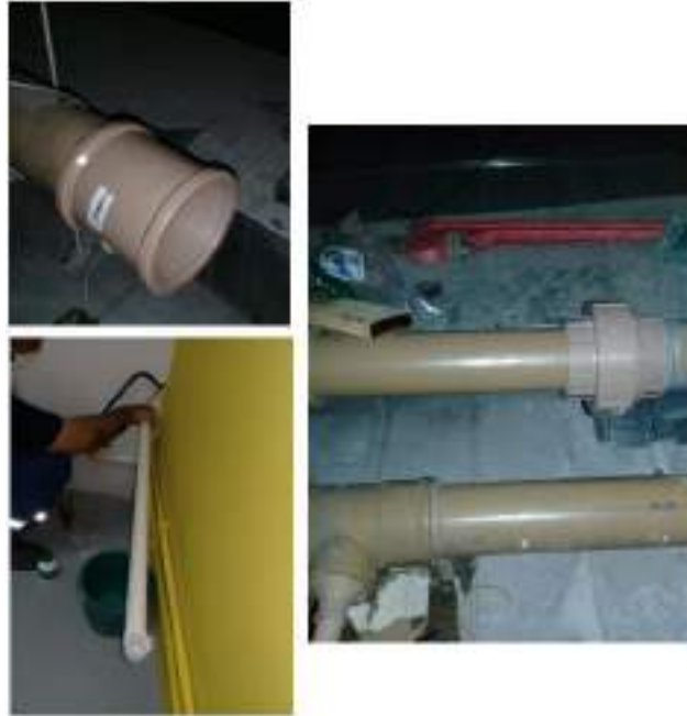
Reparos e instalações Hidráulicas diversas.
