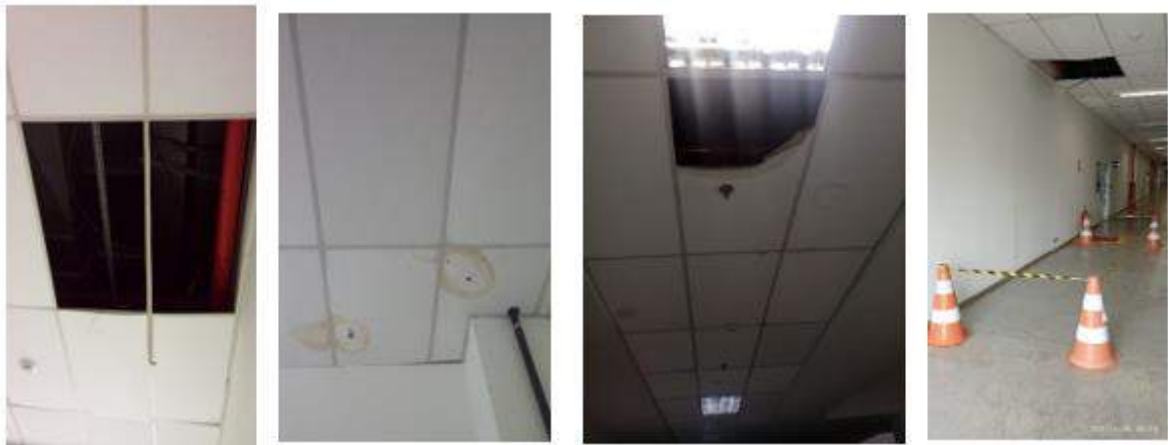
Trocas de Forros.
