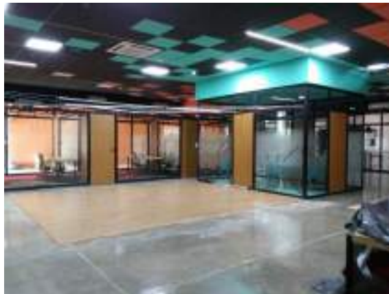
Instalação de Piso Laminado
