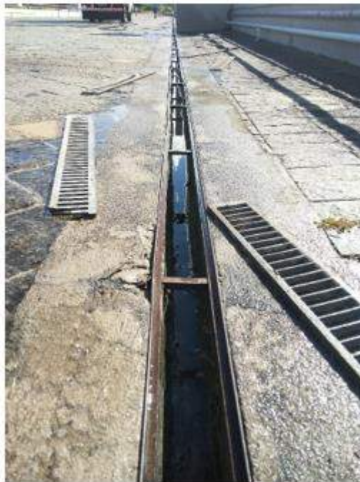
Limpeza e desentupimento de grelhas e tubulação de águas pluviais na Laje (acima da Aeroconcept e Visiona).
