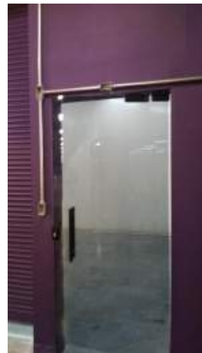
Pintura e abertura de vão para instalação de porta de acesso do Nexus para Corredor Embraer/Faculdade Santo Antônio.
