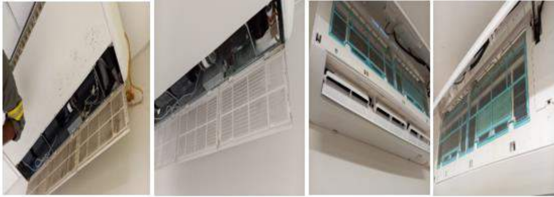
Manutenção em Equipamentos de Ar-condicionado.
