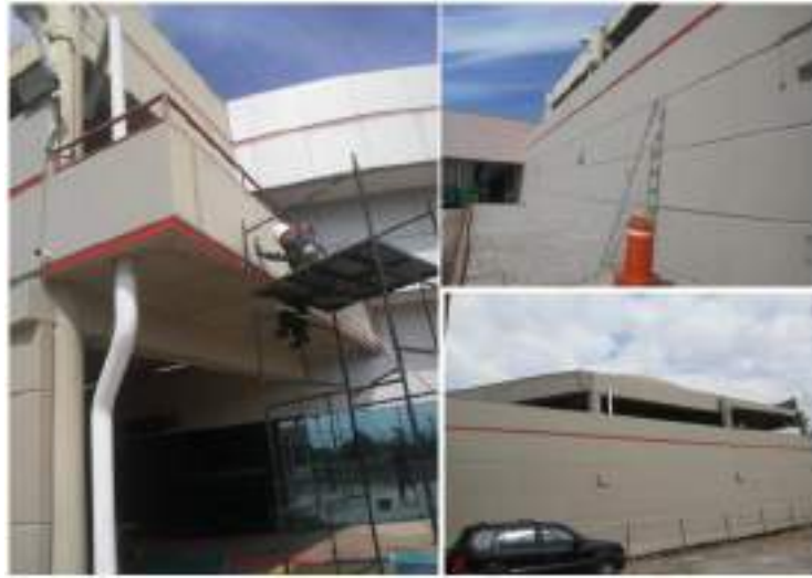
Pintura das fachadas CE I e lateral do Auditório.
