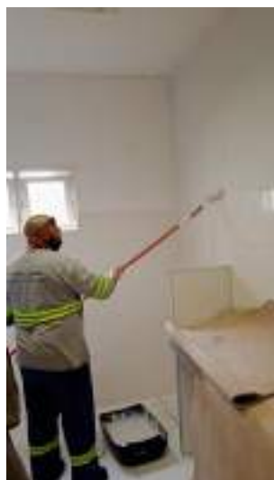
Pintura Banheiros CDM.
