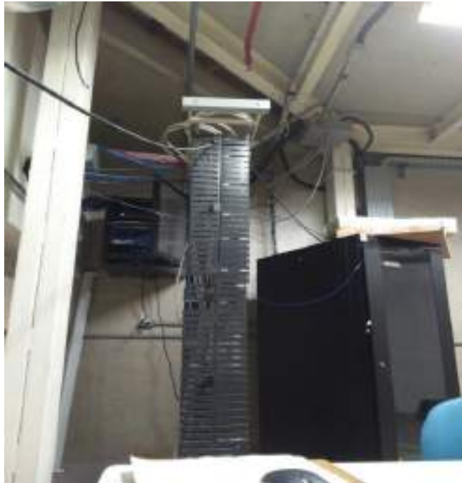
Rack sendo montado para recebimento dos Equipamentos
