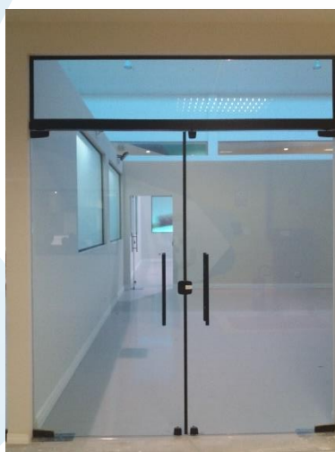
Adequação de área no Centro Empresarial II para laboratório Unifesp.
