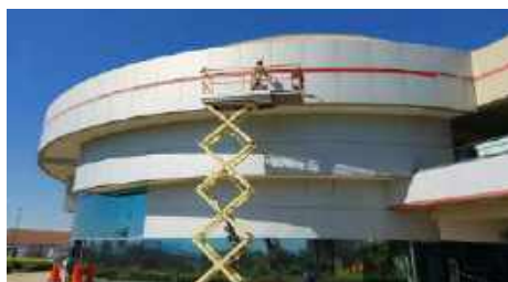
Lavagem e pintura das fachadas
